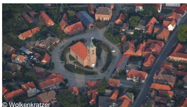
Abb. I-4: Luftaufnahme der Marienkirche zu Neuhaus mit Kirchplatz
